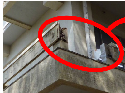
老朽化により手すりが落下
