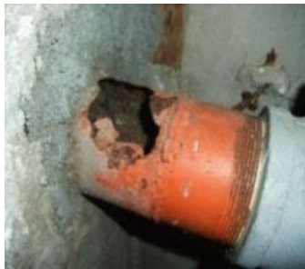
劣化による配管破損
