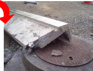
老朽化により手すりが落下
